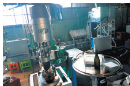
洗瓶機ポンプの更新
