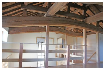
吹き抜け上部の古材部分と新しい柱
